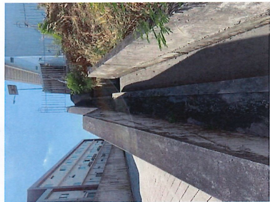
ภาพที่ 16 รางระบายน้ำฝนที่เชื่อมต่อกับระบบระบายน้ำฝนของนิคม
