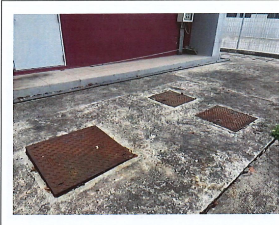
ภาพที่ 13 บ่อพักน้ำทิ้ง ขนาด 75 ลบ.ม.
