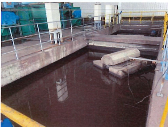
ภาพที่ 9 ถังบำบัดน้ำเสียสำเร็จรูปจากกระบวนการผลิต
