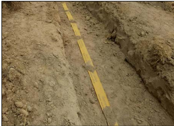
ติดตั้งแถบเตือนแนววางท่อบนหลังท่อ
