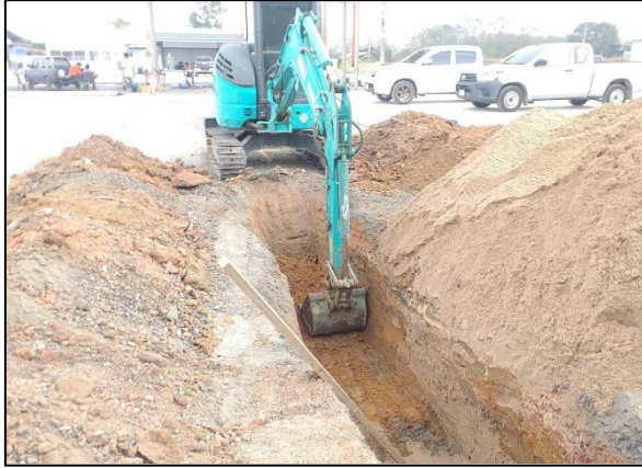
การขุดร่องและนำท่อลงร่องขุด
