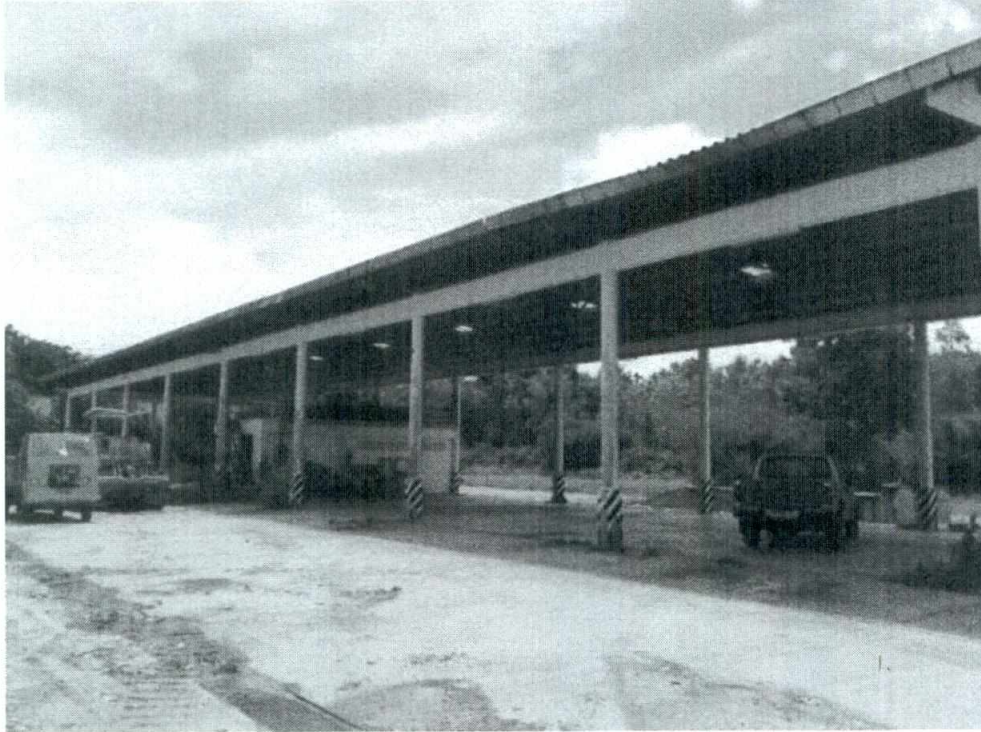
รูปที่ 1 การเทพื้นคอนกรีต และวางรับน้ำโดยรอบเพื่อป้องกันการรั่วไหลของน้ำมันและไขมัน
