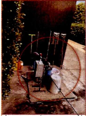
บ่อน้ำบาดาล 2 ใบอนุญาตเลขที่ 48-50460-0257 อนุญาตเมื่อ 23 ม.ค. 2561
