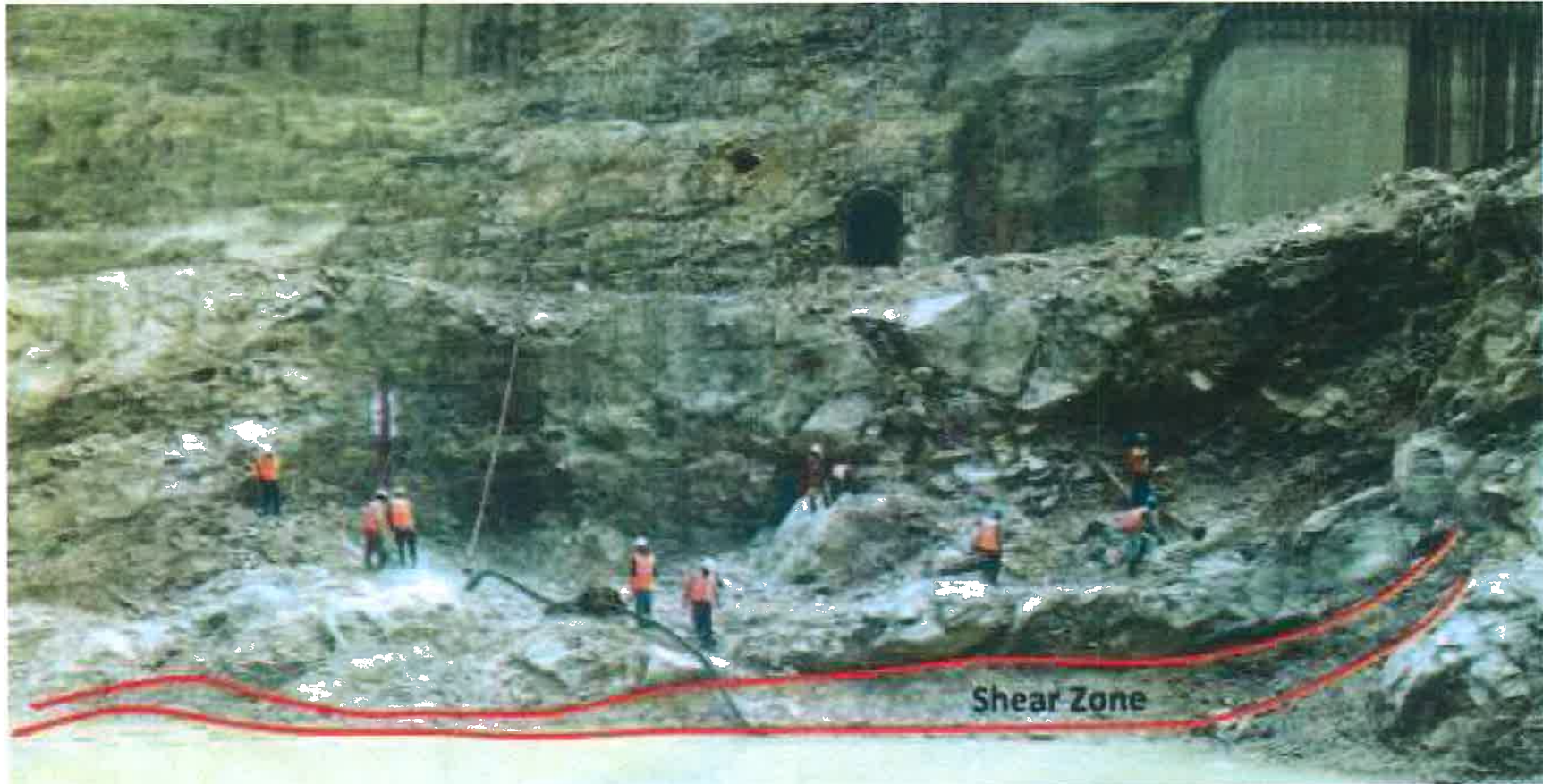
รูปที่ 1 ตัวอย่าง Shear Zone ใต้ฐานรากเขื่อน
