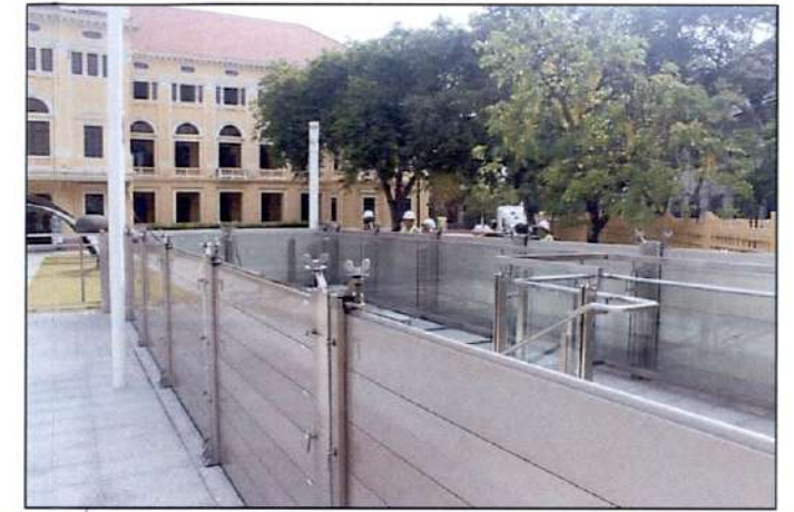
ภาพถ่ายตัวอย่าง Stop Log บริเวณรถไฟฟ้าฟ้ามหานครสายเฉลิมรัชมงคล (MRT) สถานีสนามไชย เขตพระนคร (สืบค้นข้อมูล 11 กรกฎาคม 2565)
