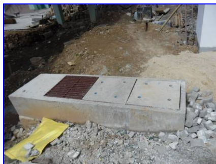
รูปที่ 2.2.9 ตะแกรงดัักขยะ
