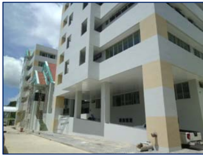
รูปที่ 2.2.10 โครงสร้างอาคาร
