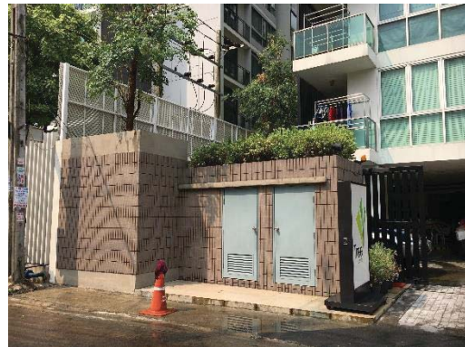
ห้องพักขยะรวม
