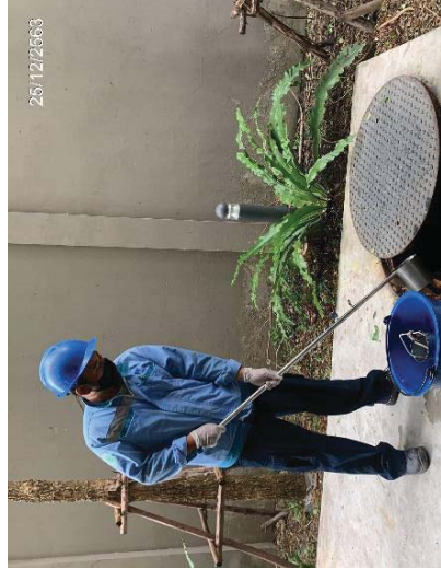
น้ำเสียออกจากระบบบำบัด A
