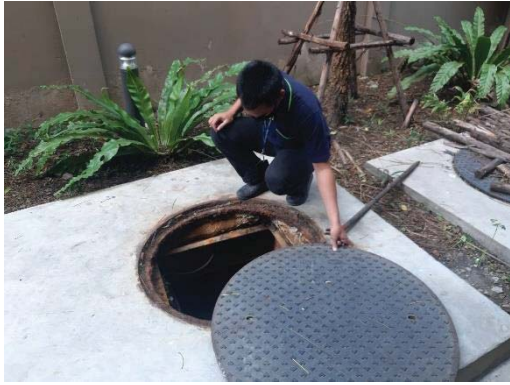
ตรวจสอบระบบบำบัด
