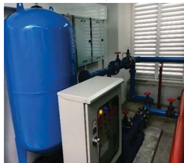
ภาพที่ 1.3.4-2 ถังเก็บน้ำชั้นดาดฟ้า และระบบปั๊มน้ำ
