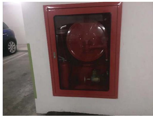
ตู้เก็บสายฉีดน้ำดับเพลิง
