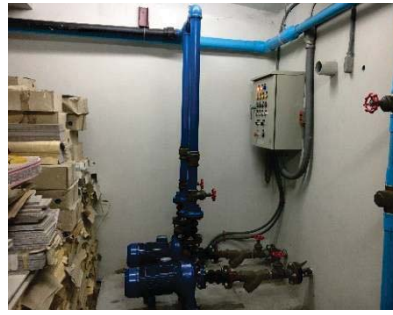
ภาพที่ 1.3.4-1 ถังเก็บน้ำชั้นใต้ดิน และระบบปั๊มน้ำ
