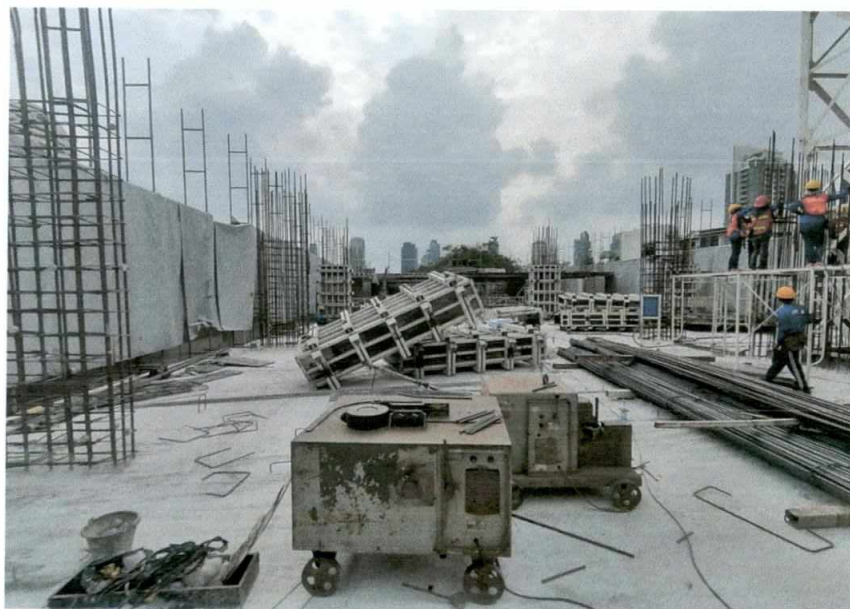
ภาพถ่ายอาคารโครงการปัจจุบัน อยู่ระหว่างดำเนินการก่อสร้างอาคารชั้น 4 ประมาณ 35% (ณ วันที่ 21 มีนาคม 2565)
