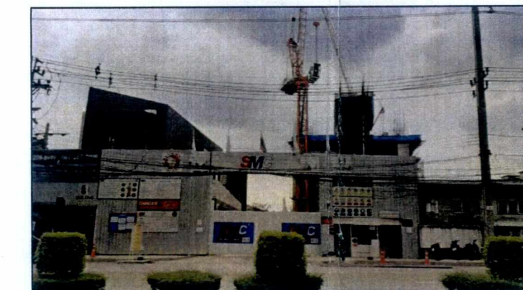
3 โครงการอาคารชุดพักอาศัย Ken Attitude Rattanathibet ขนาดความสูง 31 ชั้น
