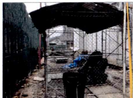
จุดพักมูลฝอยรวมช่วงก่อสร้าง
