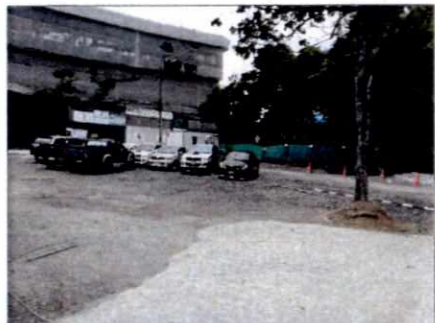
ลานจอดรถช่วงก่อสร้างบริเวณพื้นที่เช่า
