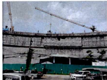
เครนภายในพื้นที่ก่อสร้าง
