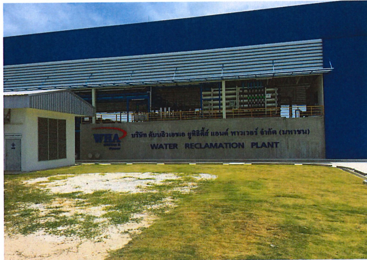
พื้นที่ระบบการนำน้ำทิ้งกลับมาใช้ใหม่ (Water Reclamation Project ระยะที่ 1)
