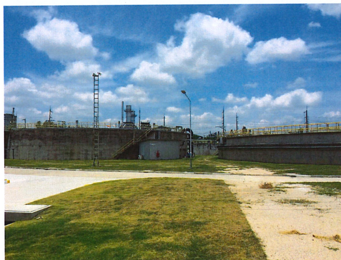
พื้นที่ระบบการนำน้ำทิ้งกลับมาใช้ใหม่ (Water Reclamation Project ระยะที่ 3)
