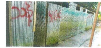
ตำแหน่งห้องส้วมบ้านพักคนงานก่อสร้าง
