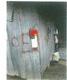
ตำแหน่งติดตั้งถังดับเพลิงเคมีแห้ง
