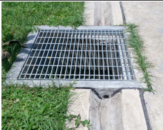
ภาพที่ 2-7 ตะแกรงดักขยะรางระบายน้ำ
