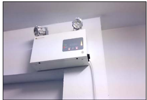
ภาพที่ 2-9 ระบบไฟฟ้าฉุกเฉิน
