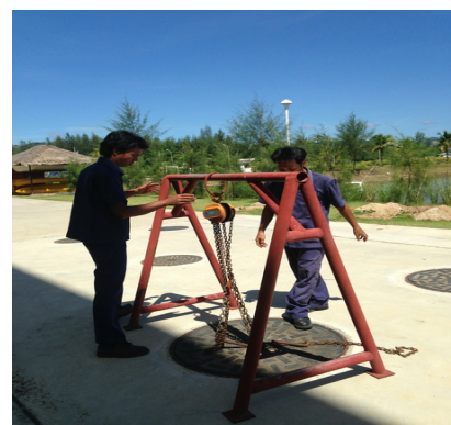
ภาพที่ 2-2 ช่างประจำประจำโครงการ และการตัดไขมันออกจากระบบ
