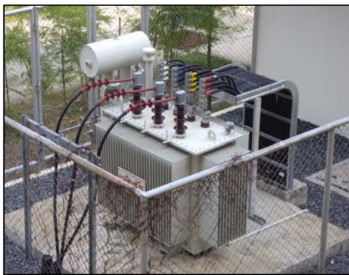
ภาพที่ 1-12 หม้อแปลงไฟฟ้าประจำโครงการฯ
