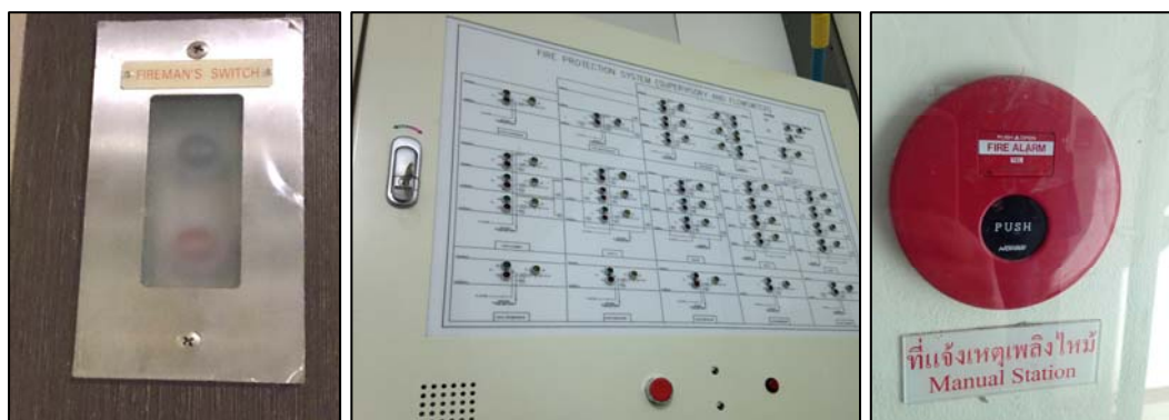
ภาพที่ 1-14 ที่แจ้งเหตุเพลิงไหม้และแผงควบคุม (Fire Alarm Control Panel)
