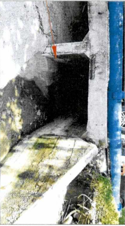
BOX CULVERT (ลอดใต้ถนน)
