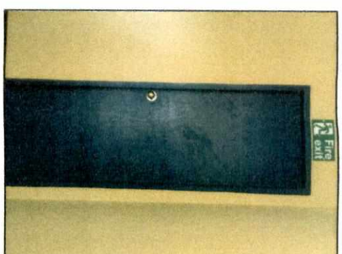
บันไดหนีไฟ
