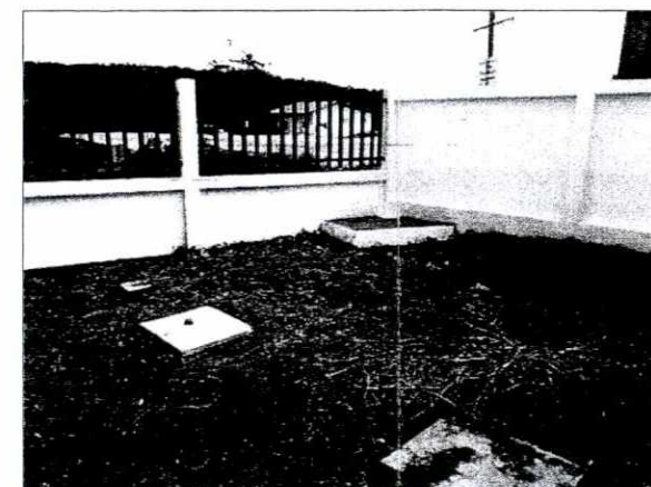
ระบบบำบัดน้ำเสียประจำอาคารบริการ (อาคาร A) ขนาด 6 ลบ.ม./วัน
