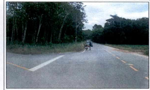
ทางสาธารณะบริเวณที่ 6
