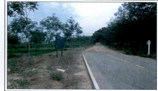
ทางสาธารณะบริเวณที่ 7
