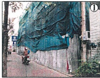
การก่อสร้างอาคารพาณิชย์ ความสูง 4 ชั้น ระยะห่างจากโครงการ 170 เมตร
