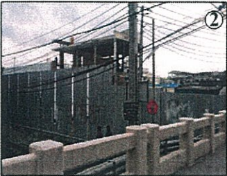
การปรับถมพื้นที่และก่อสร้างสำนักงานขาย ของบริษัท จี ดี ที พร็อพเพอร์ตี้ จำกัด ระยะห่างจากโครงการ 550 เมตร
