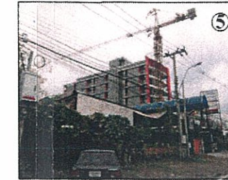
การก่อสร้างอาคารชุดพักอาศัย 8 ชั้น ระยะห่างจากโครงการ 950 เมตร
