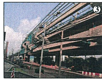
โครงการก่อสร้าง เส้นทางรถไฟฟ้า MRT และสถานียกระดับ บนถนนเพชรเกษม ระยะห่างจากโครงการ 150 เมตร
