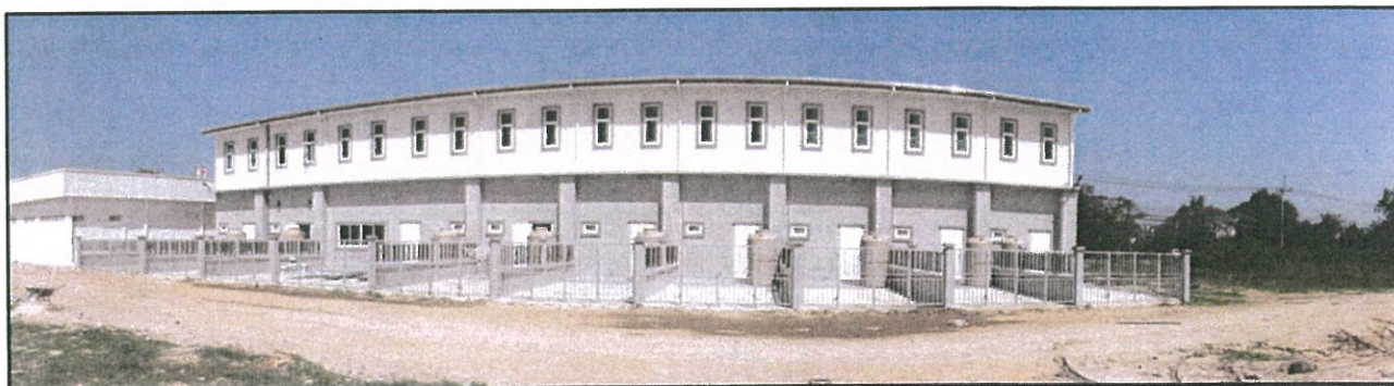
บริเวณอาคารพาณิชย์ทางทิศตะวันออกของโครงการ
