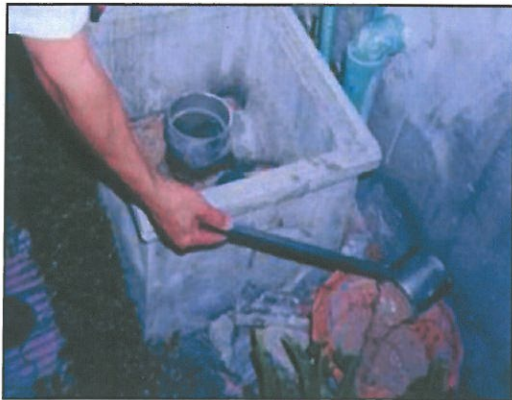
ตักกากไขมันออกจากถังดักไขมัน (รองที่กั้นกระถางด้วยกระดาษทิชชู)
