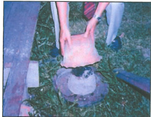
ตักกากไขมันออกจากถังดักไขมัน (รองที่กั้นกระถางด้วยกระดาษทิชชู)
