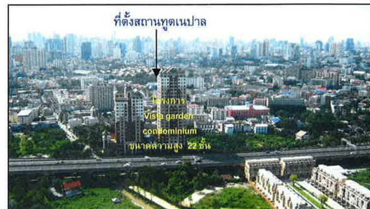
ภาพมุมมองจากโครงการ The Base อาคาร B
