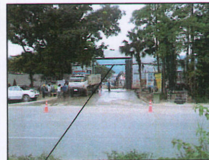
พื้นที่กำลังก่อสร้าง (กาดน้อย)
