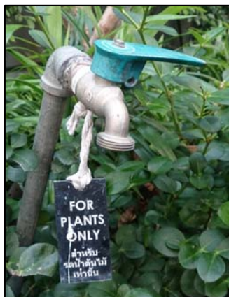
ภาพที่ 1-4 น้ำเสียที่ผ่านการบำบัดและนำกลับมาใช้รดน้ำต้นไม้ในโครงการฯ
