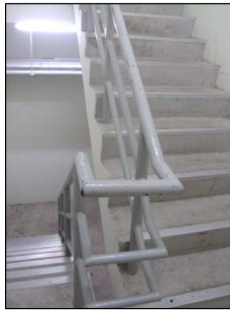
ภาพที่ 1-20 บันไดหนีไฟ
