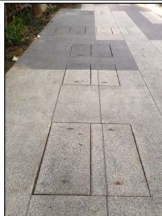
ภาพที่ 1-3 ระบบบำบัดน้ำเสีย
