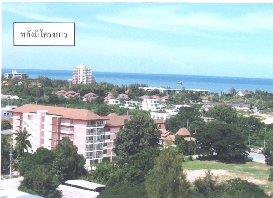
รูปที่ 11(ต่อ 2) ภาพ Perspective ก่อนและหลังมีการก่อสร้างโครงการคชาทอง (มุมมองจากโรงพยาบาลหัวหิน มองมายังโครงการคชาทอง) สำเนาถูกต้อง
