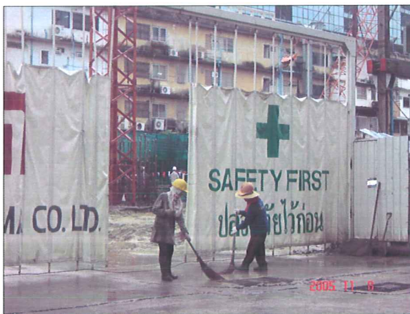
ค. การกวดฝุ่นละอองบริเวณพื้นที่ก่อสร้าง
