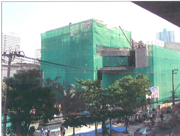
ข. การติดตั้งแผงตาข่ายเพื่อป้องกันฝุ่นละออง
