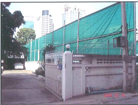
ภาพที่ 1 ตัวอย่างการควบคุมฝุ่นละอองและการติดตั้งแผงตาข่ายขณะดำเนินการก่อสร้าง
