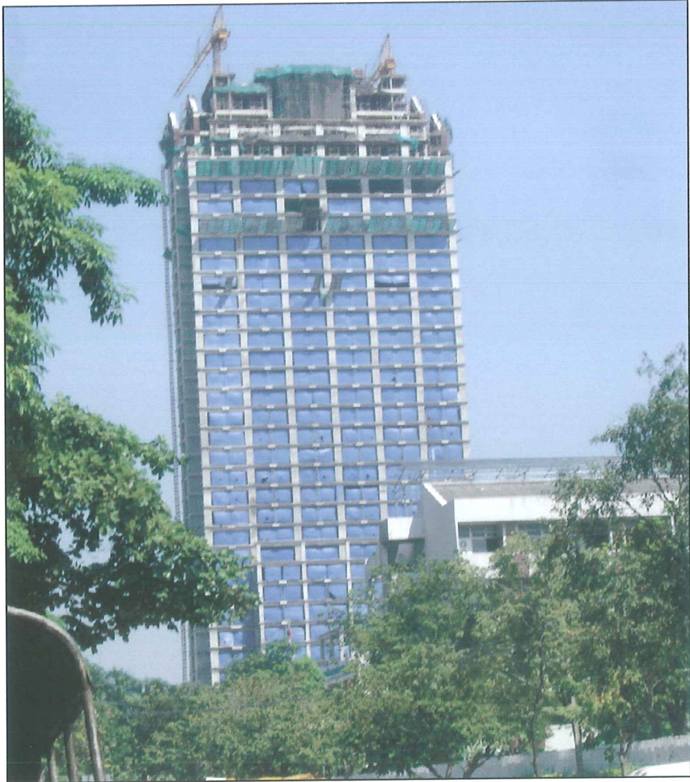
ภาพที่ 2 ตัวอย่างลักษณะการติดตั้งแผงตาข่ายบนตัวอาคาร
