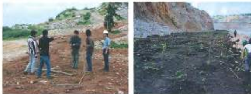
การนำดินคุณภาพต่ำบนหน้าเหมืองมาใช้ในการปรับถมฟื้นฟูสภาพเหมือง
