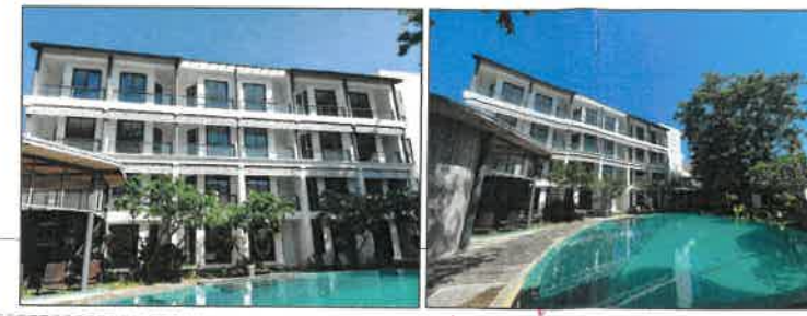
อาคาร B (อาคารห้องพัก 4 ชั้น)
