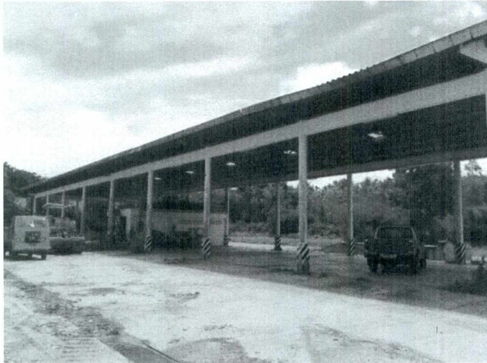
รูปที่ 1 การเทพื้นคอนกรีต และวางรับน้ำโดยรอบเพื่อป้องกันการรั่วไหลของน้ำมันและไขมัน
