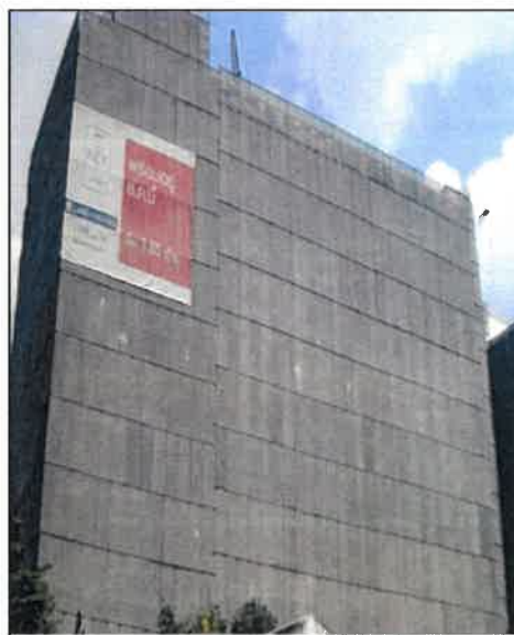
ภาพตัวอย่างการติดตั้งตาข่ายกันฝุ่น (Mesh Sheet) คลุมอาคารที่กำลังก่อสร้าง
