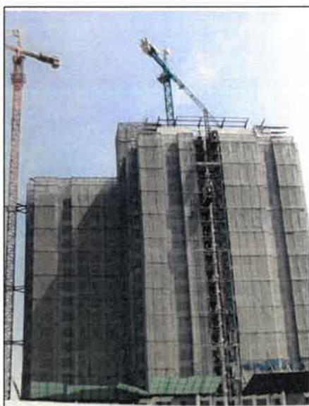
ภาพตัวอย่างการติดตั้งตาข่ายกันฝุ่น (Mesh Sheet) คลุมอาคารที่กำลังก่อสร้าง
