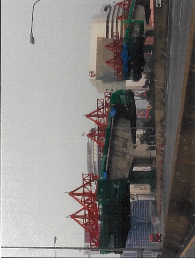
รูปที่ 11 ตัวอย่างแสดงการติดตั้งตาข่ายป้องกันเศษวัสดุตกหล่น (Raschel Net)
