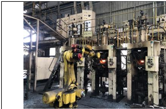
ภาพที่ 20 พื้นที่ที่ติดตั้งเครื่องจักรที่มีความร้อน
