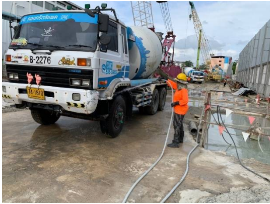
ภาพที่ 7 การฉีดล้างล้อรถก่อนออกจากพื้นที่ก่อสร้าง
