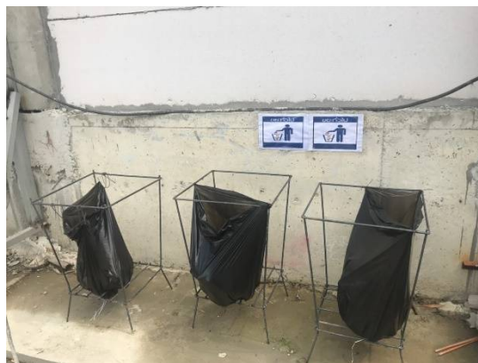
ภาพที่ 12 ถังขยะเพื่อรองรับมูลฝอยภายในพื้นที่ก่อสร้าง
