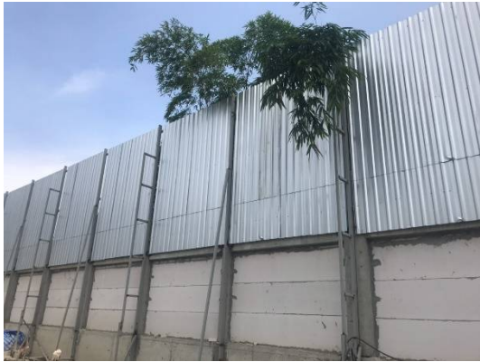
ภาพที่ 1 รั้ว Metal Sheet สูง 6 เมตร
