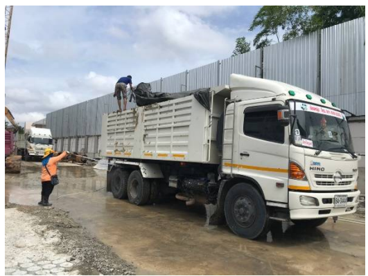
ภาพที่ 5 การปิดคลุมผ้ารถบรรทุกขนดิน
