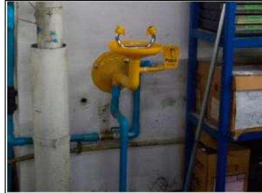
ภาพที่ 28 ฝักบัวและอ่างล้างตา
