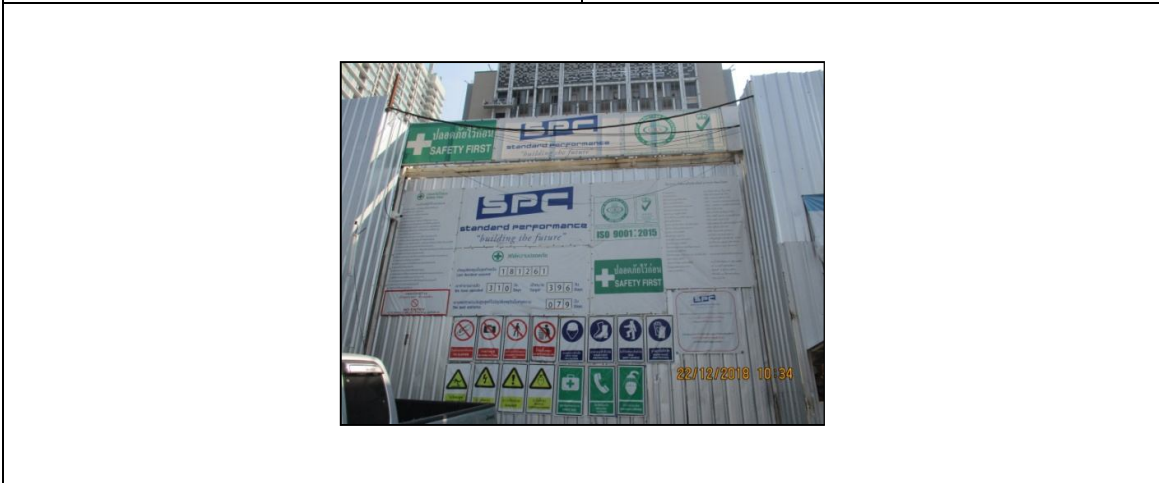
ภาพที่ 1.6-1 สถานภาพการก่อสร้างโครงการขณะทำการสำรวจ
