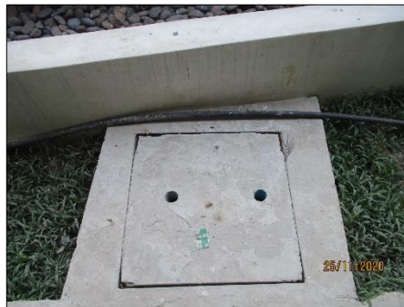
รูปที่ 1-5 ท่อระบายน้ำภายในพื้นที่โครงการ
