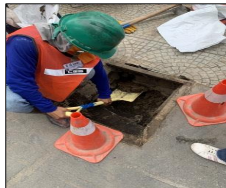
รูปที่ 1-4 การทำความสะอาดบ่อพักน้ำชั่วคราวและบ่อดักตะกอนดิน
