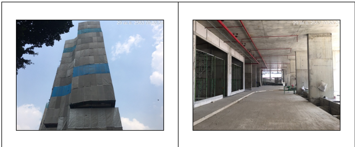
รูปที่ 2.2-1 สภาพพื้นที่โครงการในปัจจุบัน
