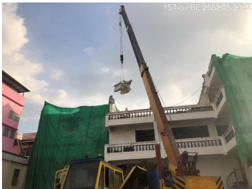
รูปที่ 9 การลำเลียงวัสดุรื้อถอนโดยใช้เครนในการขนย้าย
