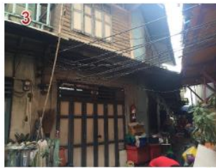
ทิศตะวันตก ติดกับกลุ่มอาคารพักอาศัย สูง 2 ชั้น
