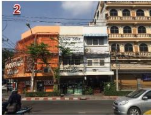
ทิศตะวันตก ติดกลุ่มอาคารพาณิชย์ สูง 3 ชั้น
