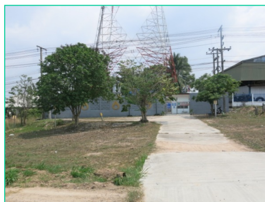
สถานีควบคุมความดันและวัดปริมาตรก๊าซ (MRS)
