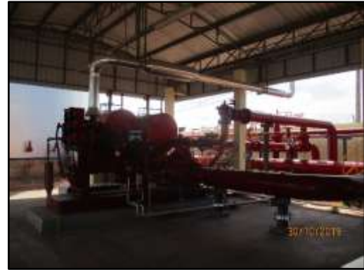
รูปที่ 2-23 เครื่องสูบน้ำดับเพลิง
