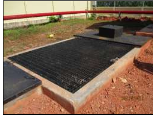
บ่อพักน้ำเสีย
