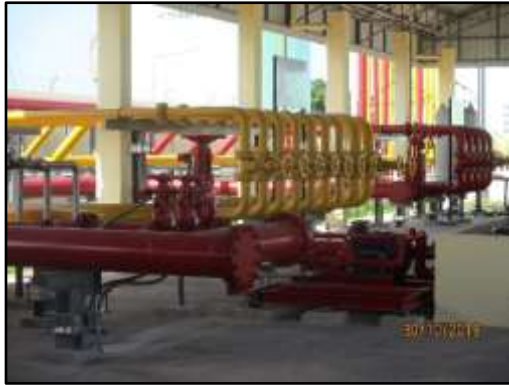
รูปที่ 2-23 เครื่องสูบน้ำดับเพลิง
