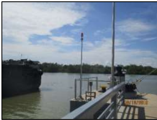
รูปที่ 2-15 การติดตั้งสัญญาณไฟกระพริบบนท่าเทียบเรือของโครงการ
