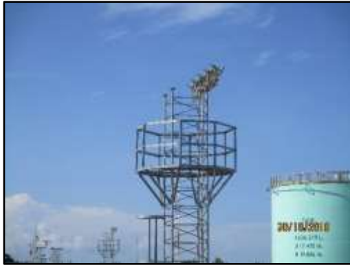
รูปที่ 2-14 การติดตั้งระบบไฟฟ้าแสงสว่างบนท่าเทียบเรือของโครงการ
