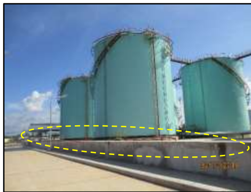
รูปที่ 2-30 คันคอนกรีตล้อมรอบถังเก็บน้ำมัน
