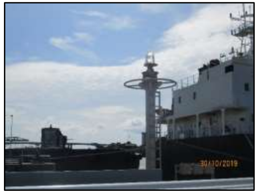
รูปที่ 2-15 การติดตั้งสัญญาณไฟกระพริบบนท่าเทียบเรือของโครงการ
