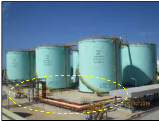
รูปที่ 2-21 ระบบฉีดน้ำดับเพลิงบริเวณถังเก็บน้ำมัน
