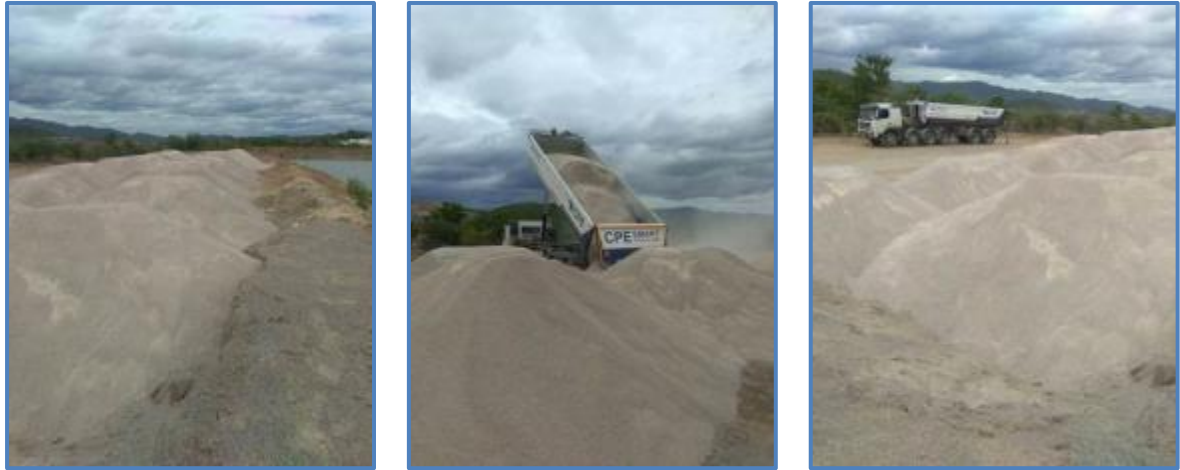
ภาพที่ 4-1 การนำหินปูนฝุ่นมาใช้บำบัดคุณภาพน้ำบริเวณชุมชนเมืองของโครงการ
