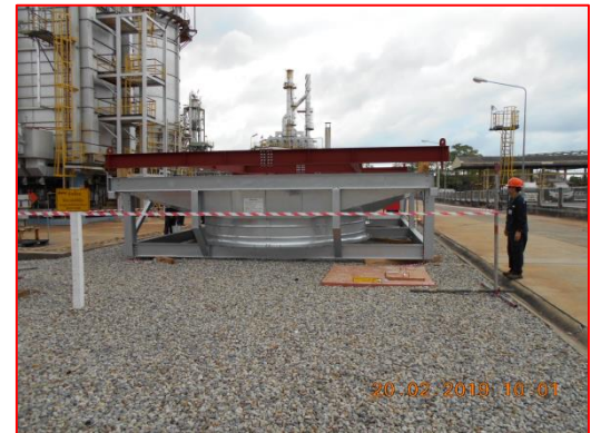
ภาพที่ 2.2-4 พื้นที่กองวัสดุอุปกรณ์ก่อสร้าง
