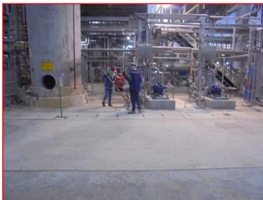
ภาพที่ 2.2-5 การทำความสะอาดเศษวัสดุก่อสร้าง และถนนบริเวณพื้นที่ก่อสร้าง
