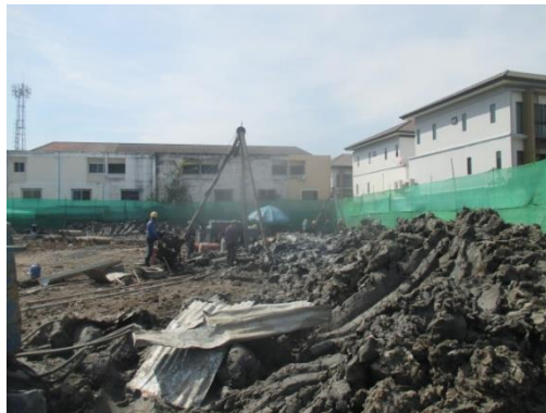
ภาพที่ 1.5-1 ความคืบหน้าการก่อสร้างโครงการ
