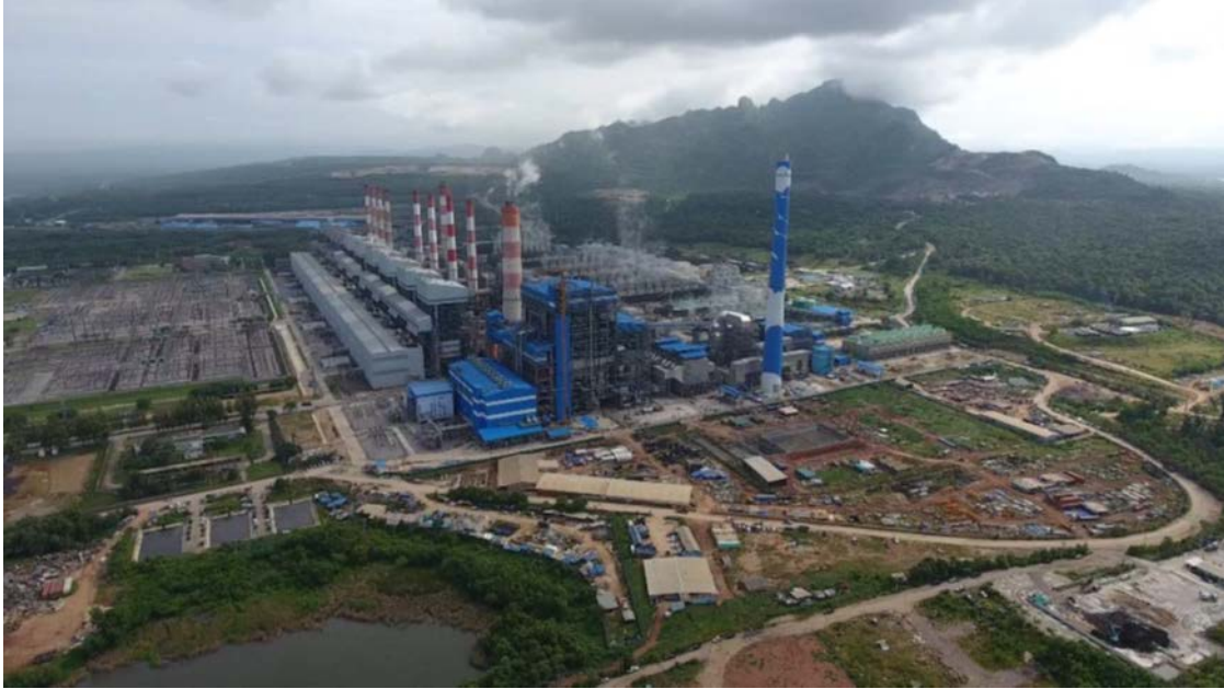
รูปที่ ๓-5 ภาพมุมสูงความก้าวหน้าการก่อสร้างโครงการพัฒนาโรงไฟฟ้าทดแทนเครื่องที่ 4-7 กันยายน 2561
