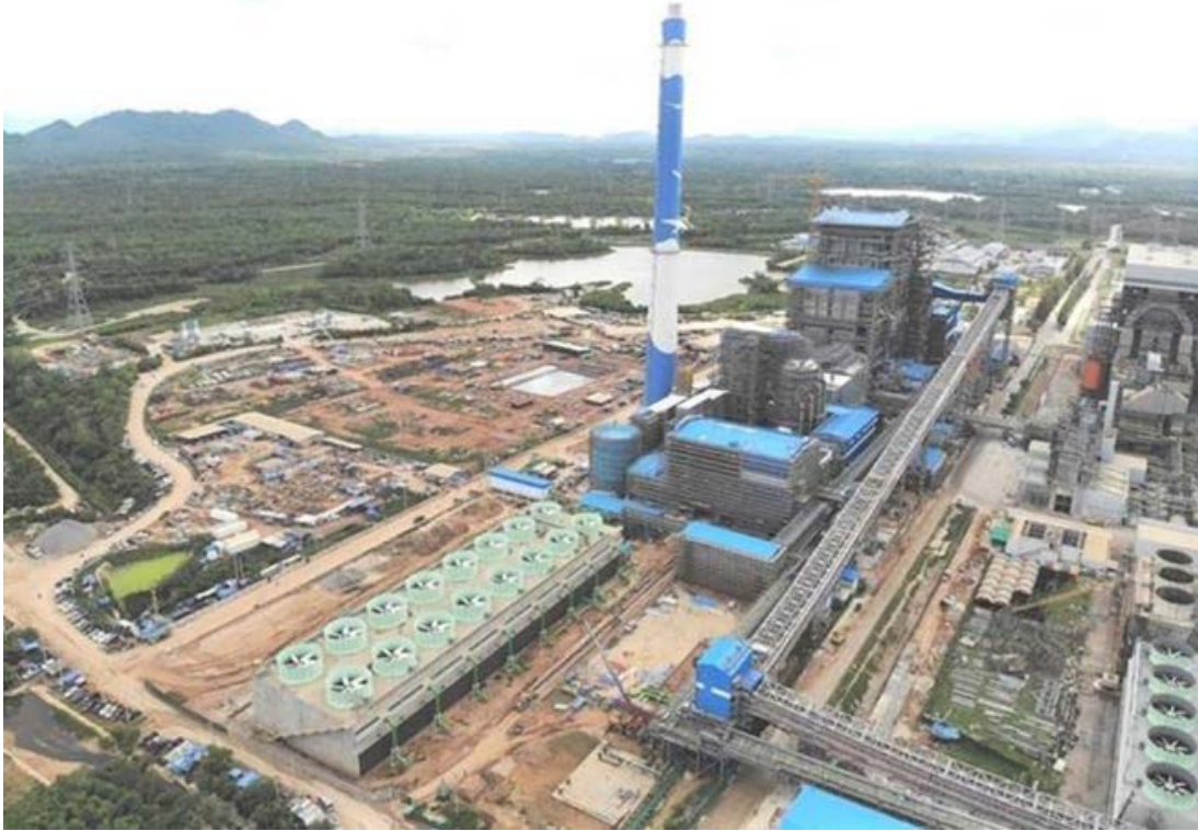
รูปที่ ๓-๓ ภาพมุมสูงความก้าวหน้าการก่อสร้างโครงการพัฒนาโรงไฟฟ้าทดแทนเครื่องที่ 4-7 กรกฎาคม 2561
