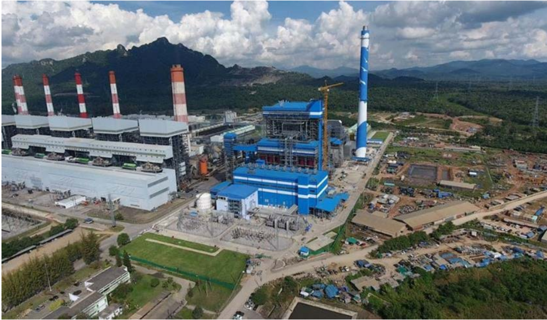
รูปที่ ๗-๗ ภาพมุมสูงความก้าวหน้าการก่อสร้างโครงการพัฒนาโรงไฟฟ้าทดแทนเครื่องที่ 4-7 พฤศจิกายน 2561
