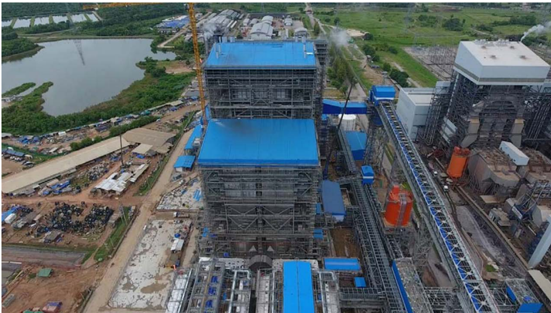
รูปที่ ๓-๔ ภาพมุมสูงความก้าวหน้าการก่อสร้างโครงการพัฒนาโรงไฟฟ้าทดแทนเครื่องที่ 4-7 สิงหาคม 2561
