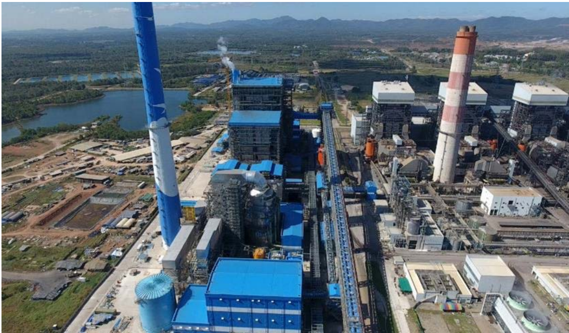
รูปที่ ๗-๘ ภาพมุมสูงความก้าวหน้าการก่อสร้างโครงการพัฒนาโรงไฟฟ้าทดแทนเครื่องที่ 4-7 ธันวาคม 2561
