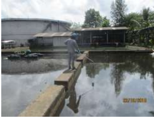
บริเวณบ่อพักน้ำทิ้งรวมก่อนระบายลงสู่ระบบบำบัดน้ำเสีย
