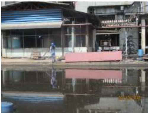
บริเวณบ่อบำบัดน้ำเสียบ่อสุดท้าย
