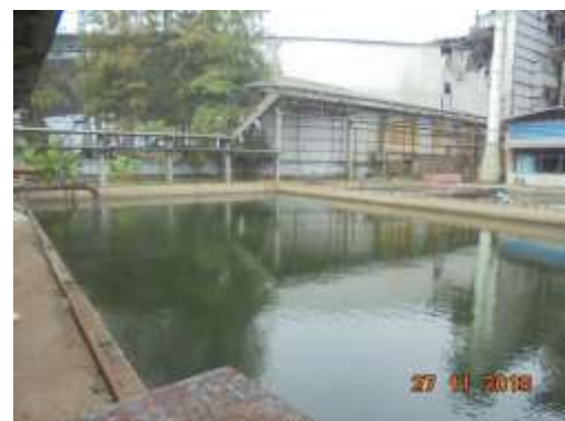
รูปที่ 19 บ่อรวบรวมน้ำฝน
