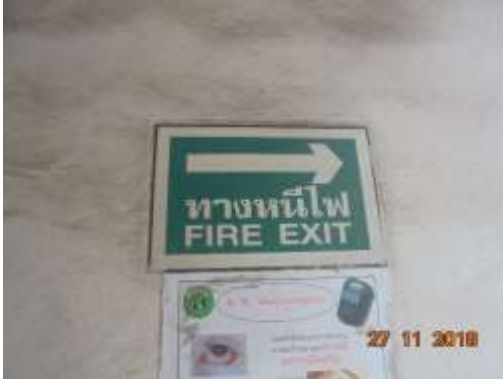
ป้ายบอกทางหนีไฟ
